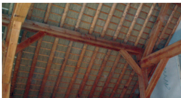
Aan de binnenkant van dit dak is riet gebruikt om te isoleren. Riet kent een goede isolerende werking, maar is wel zeer brandbaar.
