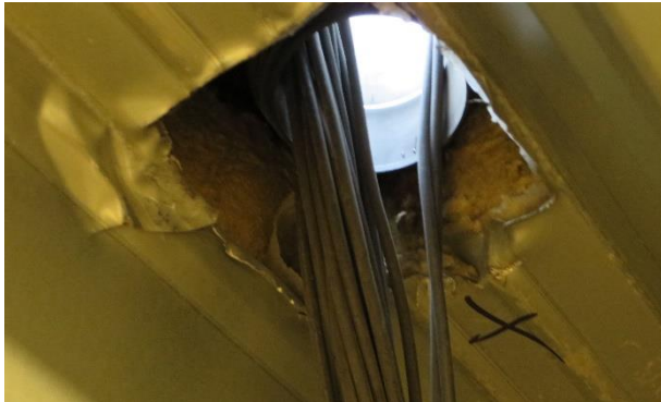
Verkeerde dakdoorvoer
